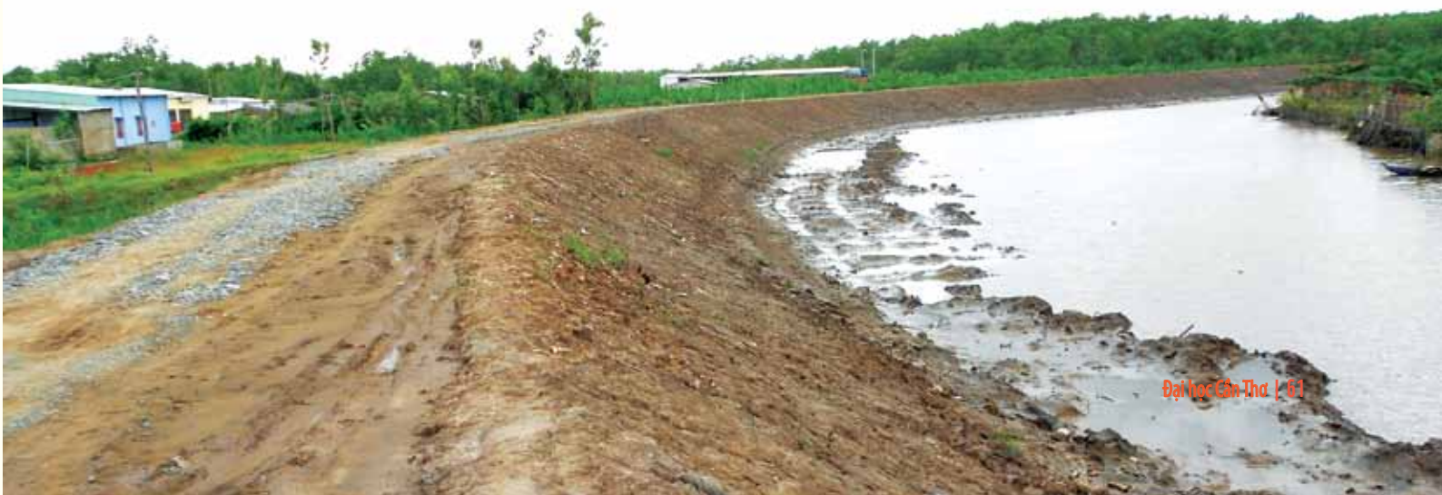
Hình 5-2: Giải pháp ứng phó: Hệ thống đê biển được xây dựng ở huyện Thạnh Phú để bảo vệ khu dân cư và các vùng sản xuất phía trong. Ngoài đê biển là hàng cây rừng ngập mặn có tác dụng chắn sóng. (Ảnh: Lê Anh Tuấn, 2011)
